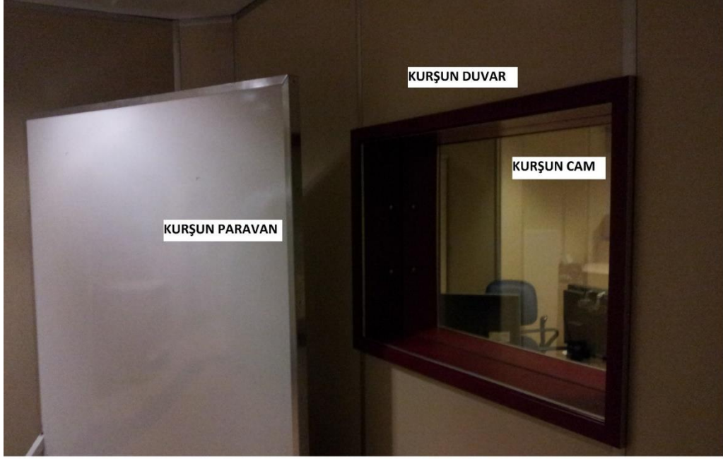
Şekil 4.21. Duvar zırhlama ve kurşun paravan
