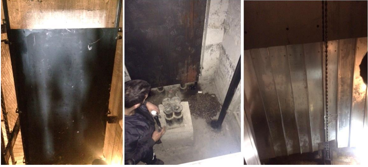
Resim 4.4. Uygun karşı ağırlık seperatörleri
