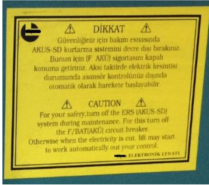
Resim 4.8. Kontrol panelindeki uyarı yazısı
