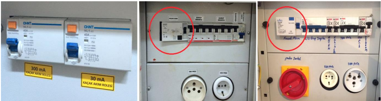
Resim 4.9. Kaçak akım röleleri
