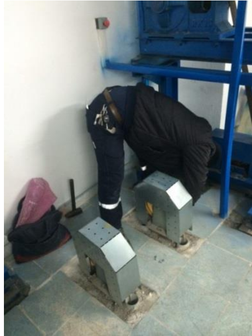
Resim 4.5. Makine dairesinde bakım sırasındaki çalışma pozisyonu
