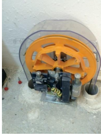
Resim 4.2. Uygun olmayan kasnak mahfazası
