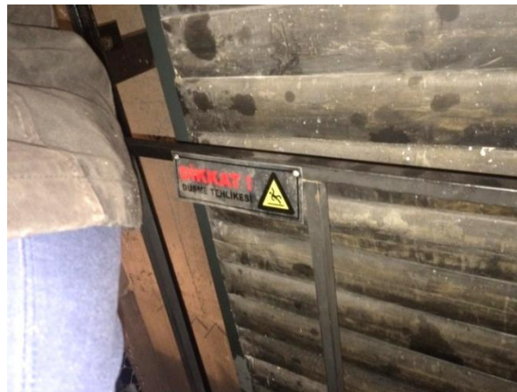
Resim 4.7. Korkuluktaki düşme tehlikesine karşı uyarı yazısı
