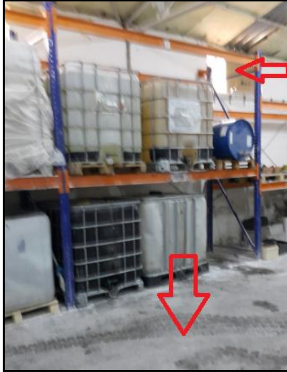
Resim 4.20. Depolama alanında yerde toz birikmesi ve içeriye ışık sızması
