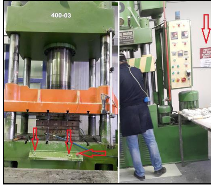
Resim 4.31. Preslerde çift el butonu ve acil stop butonu (solda) ve iki elle komuta etme ile ilgili uyarı levhası (sağda)
