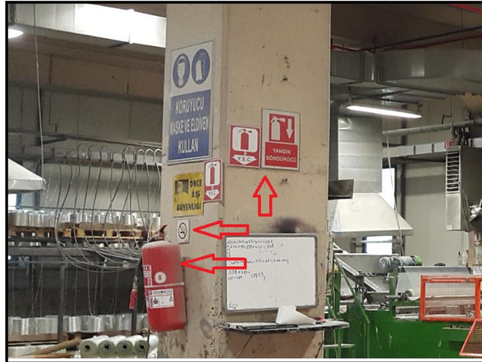
Resim 4.22. Hamurhanede yangın için alınan önlemler
