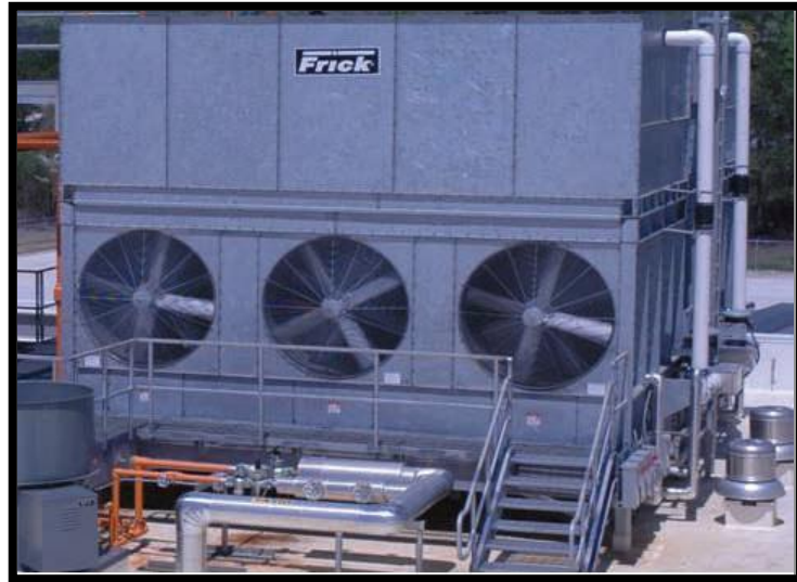
Şekil 2.13. Yoğuşturucu (Kondenser)
