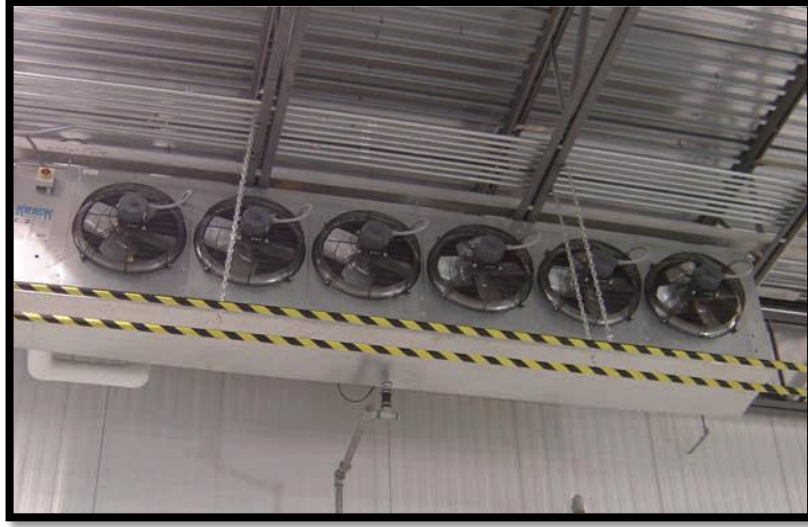
Şekil 2.12. Buharlaştırıcı (Evaporatör)
