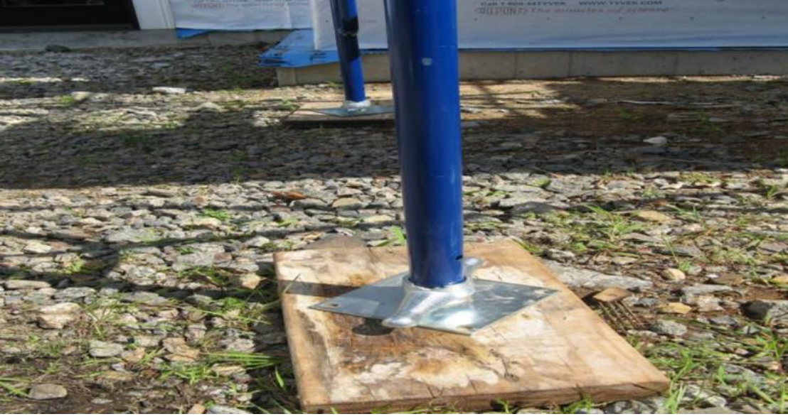
Şekil 75. Standartlara uygun iskele tabanı [23]
