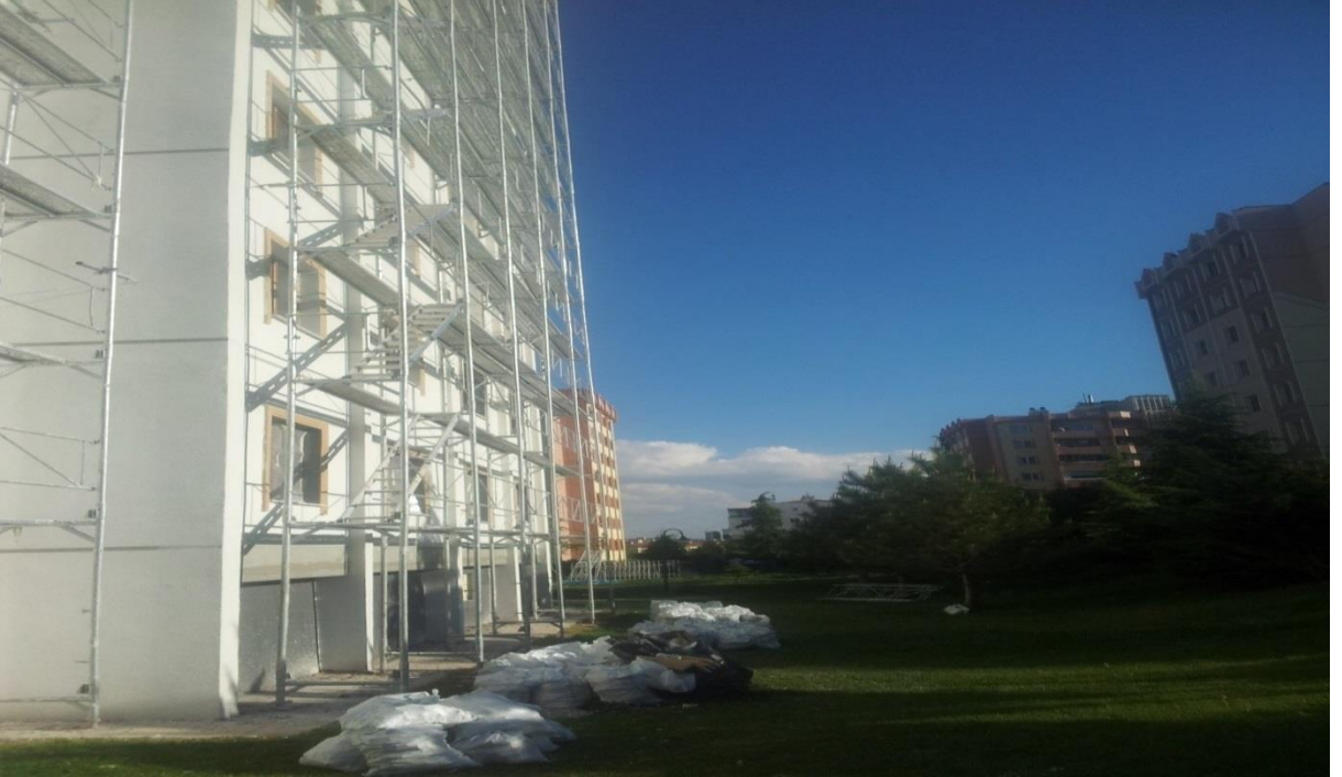
Şekil 64. Standartlara uygun iskele
