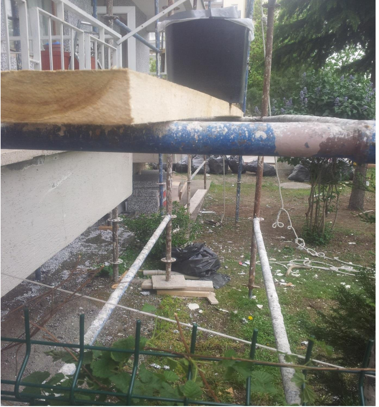
Şekil 34. Yetersiz Taban Desteği
