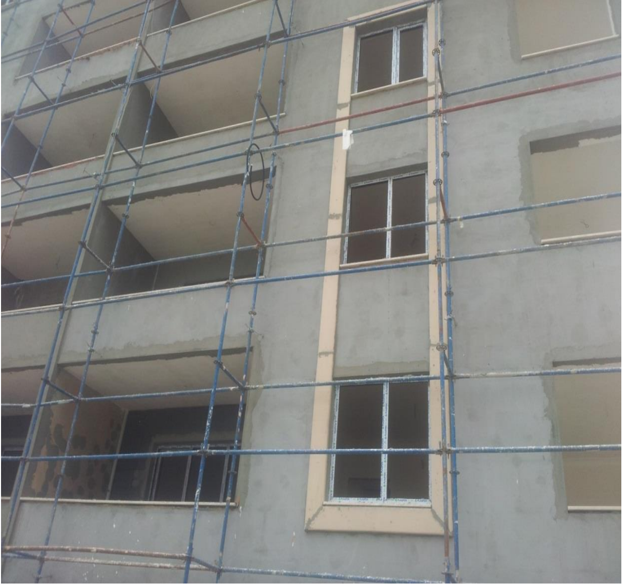
Şekil 38. Standartlara Uymayan İskelenin Önden Görünüşü
