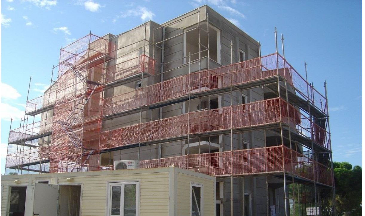
Şekil 70. Tam dolu platform, içerden merdiven sistemi iyileştirilmiş iskele
