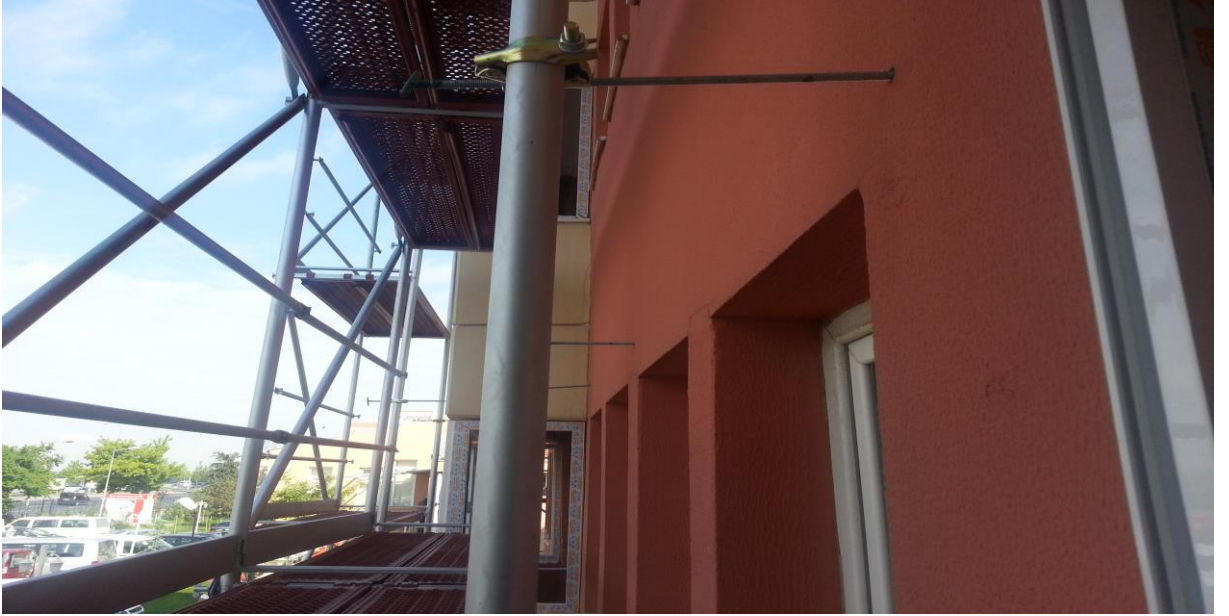
Şekil 18. İskele Bağlantı Noktası
