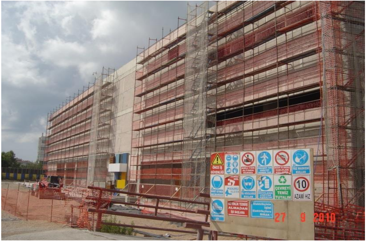
Şekil 72. İyileştirilmiş, platform ve merdiven eklenmiş iskele [22]
