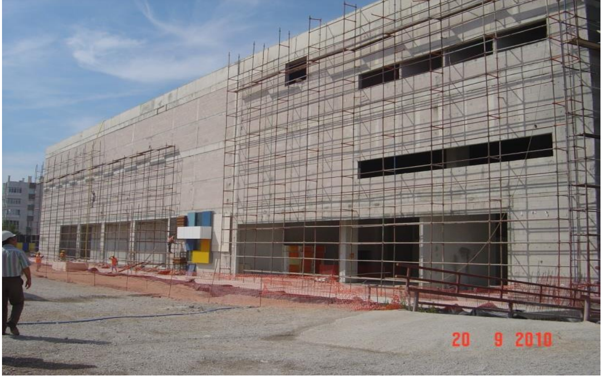
Şekil 71. Platformsuz iskele
