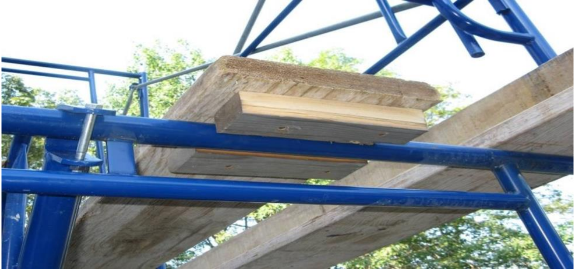
Şekil 78. Platform Kelepçeleri [24]
