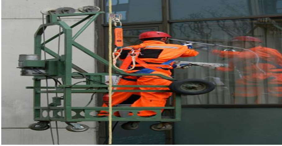
Şekil 25. Cephe Asansöründe KKD'li Çalışan
