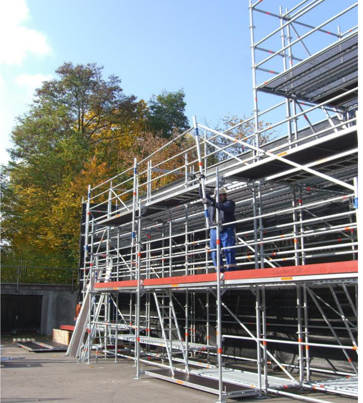
Şekil 73. Standartlara uygun iskele
