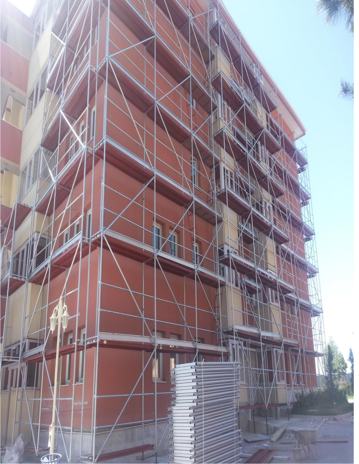
Şekil 20. Standartlara Uygun İskelenin Önden Görünüşü
