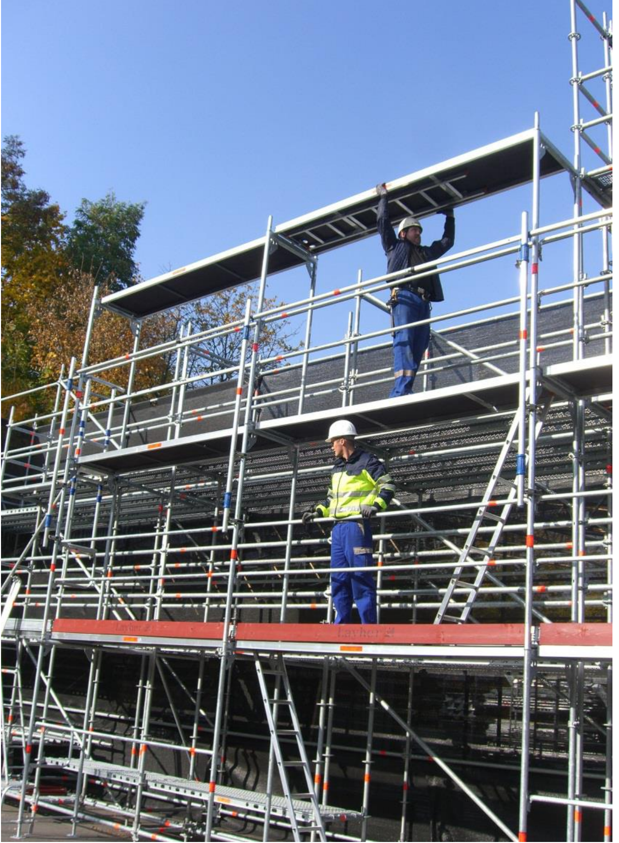
Şekil 74. Standartlara uygun iskelede bulunan üst kata çıkmadan önce üst katta çalışacak kişiyi korumak amacıyla alt kattan monte edilen korkuluklar
