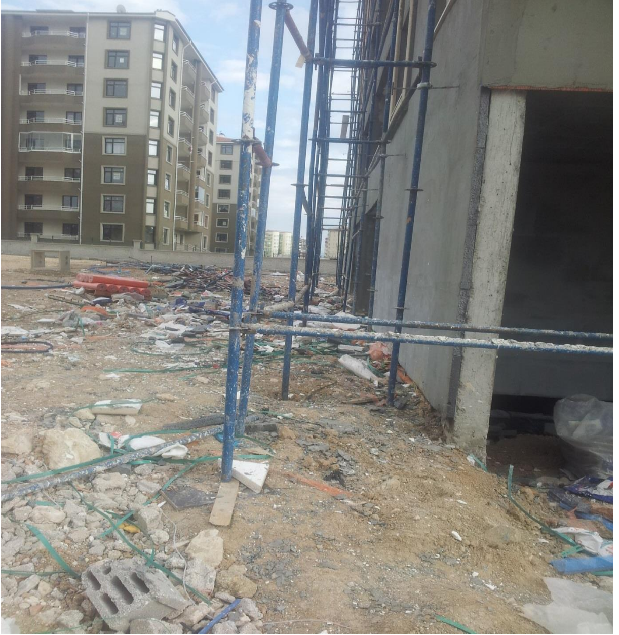
Şekil 40. Standartlara Uymayan İskele Tabanı
