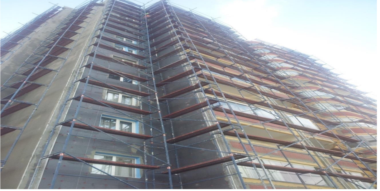
Şekil 63. Standartlara uygun iskele
