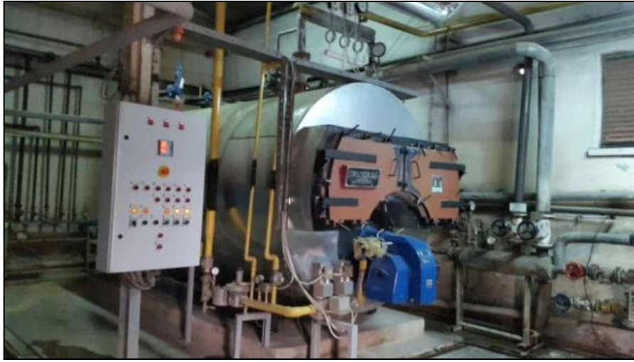
Şekil 2.11. Elektrik ve mekanik risk oluşturan etmenler
