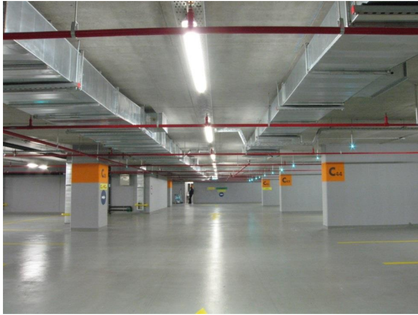
Resim 2.7. Otopark havalandırması - kanallı sistem [28]
