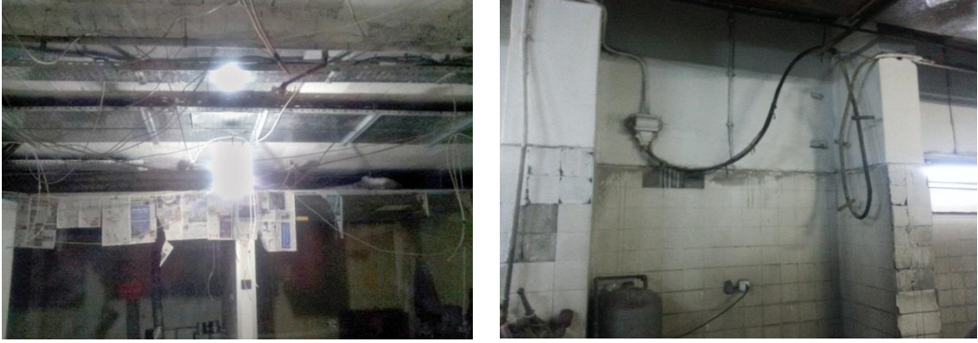
Resim 4.3. Otopark içinde düzensiz kablolar
