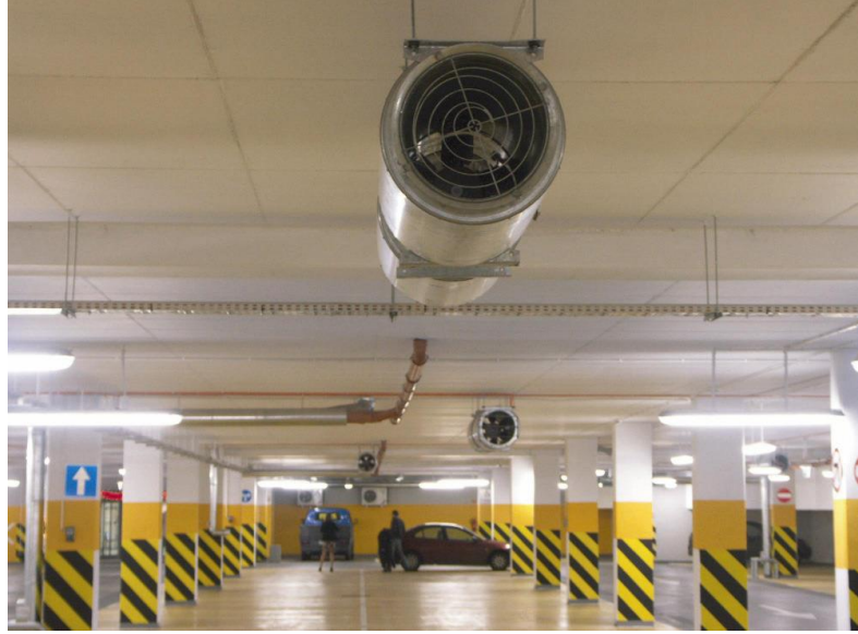
Resim 2.8. Otopark havalandırması – jet fanlı sistem [30]
