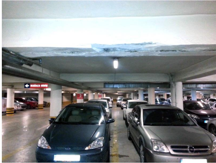
Resim 4.6. Yağmurlama sistemi bulunmayan otopark örneği
