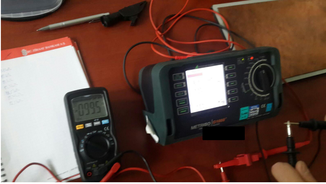
Resim 3.1. Multimetre ile gerilim kontrolü
