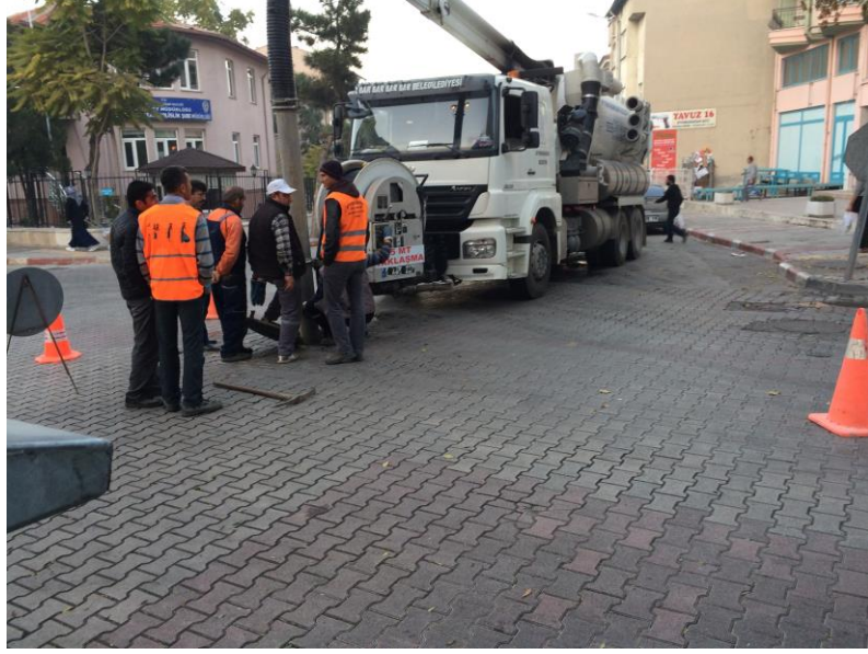
Resim 4.1. Kombine kanal açma aracı ile çalışırken gerekli trafik tedbirlerinin alınması
