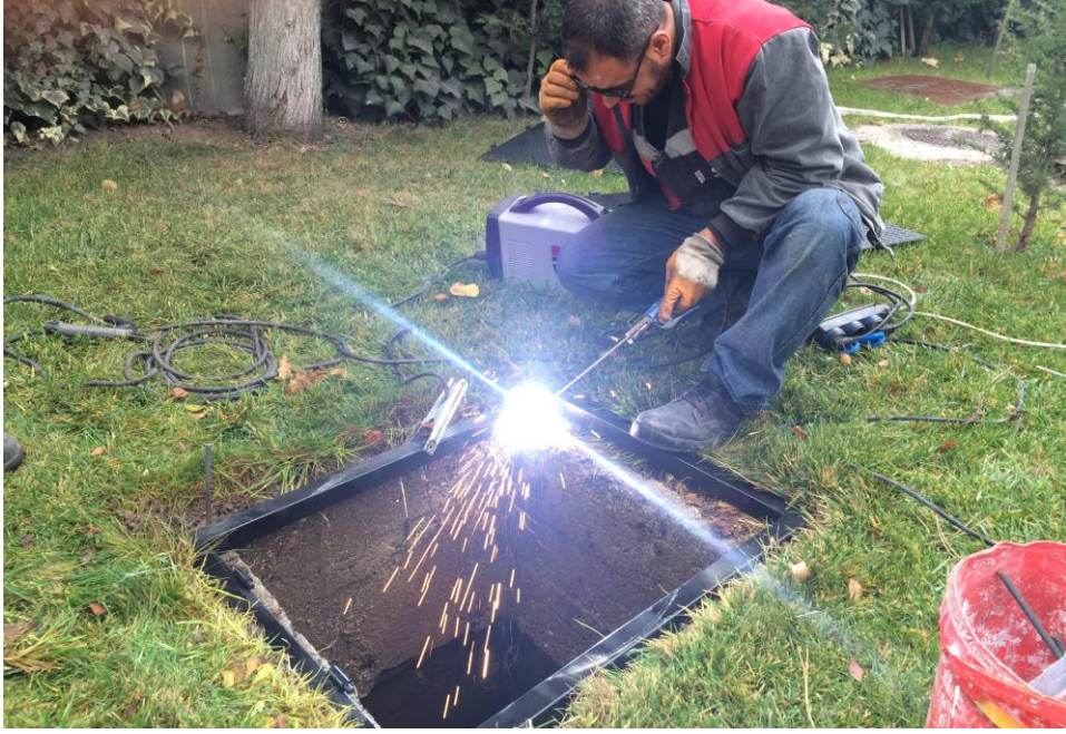
Resim 4.23. Kaynak kıvılcımı kaynaklı patlama riski
