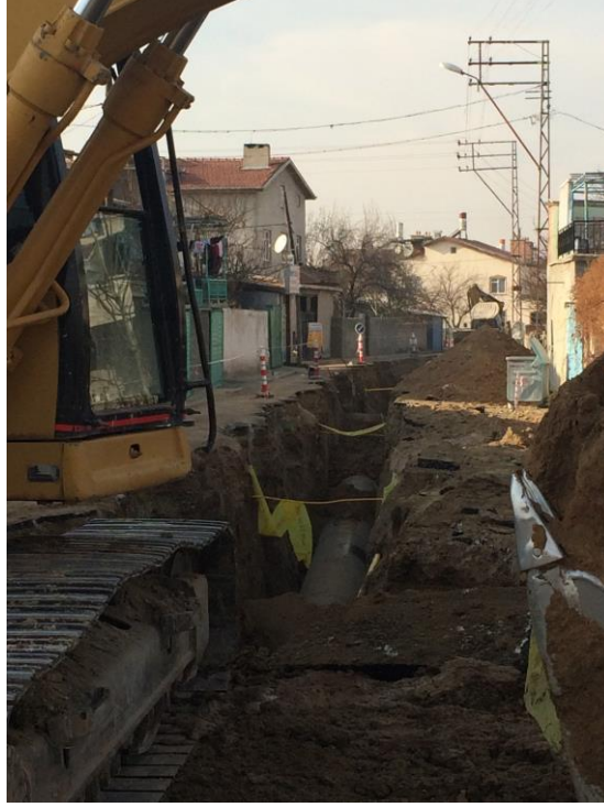
Resim 4.19. Kazı kenarına yakın bırakılan hafriyat
