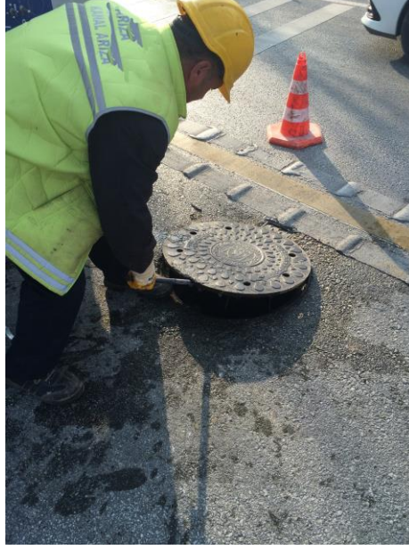
Resim 4.2. Yanlış muayene baca kapağı kaldırma işlemi
