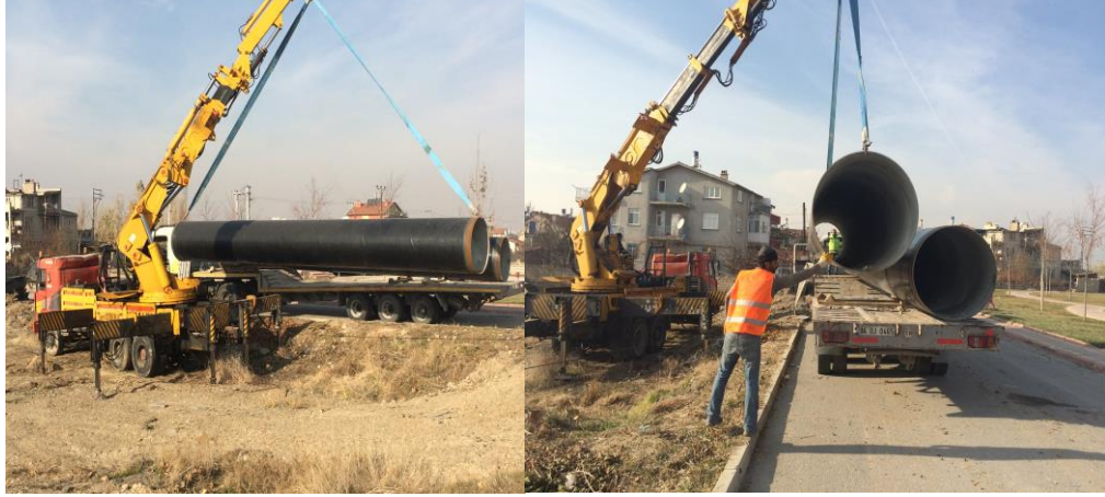
Resim 4.16. Kanalizasyon borularının indirilmesi
