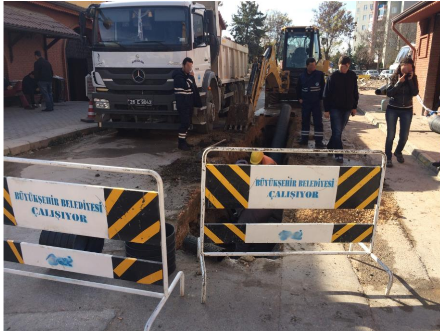
Resim 4.13. Kazı alanının panolar ile trafiğe kapatılması
