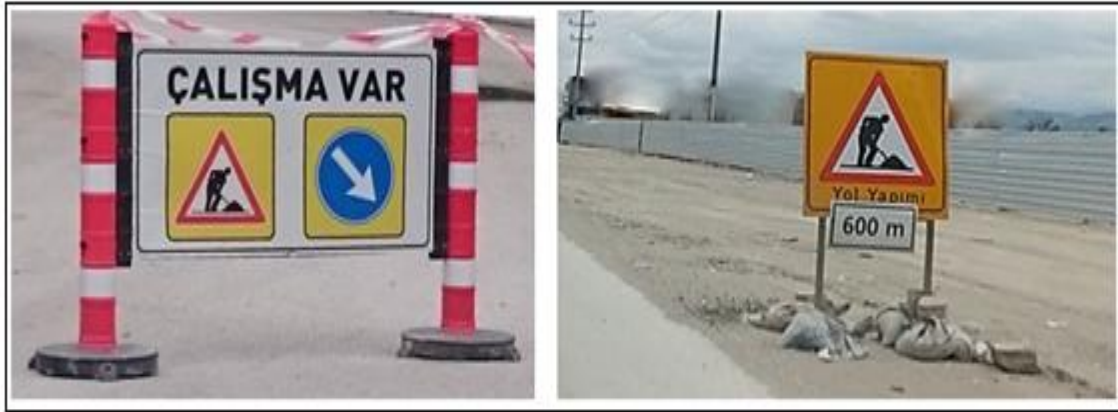
Resim 4.1. Çalışma Yapılan Yollardaki İşaretleme Örnekleri
