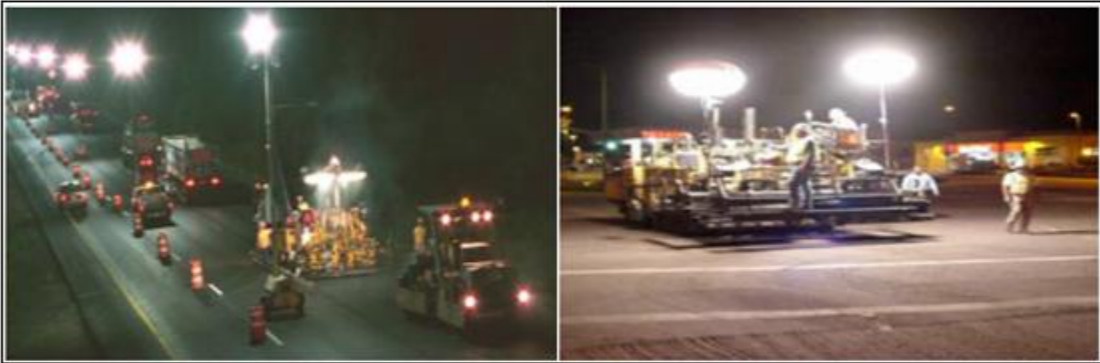
Resim 2.6. Gece Çalışmalarında Aydınlatma Örnekleri [14]
