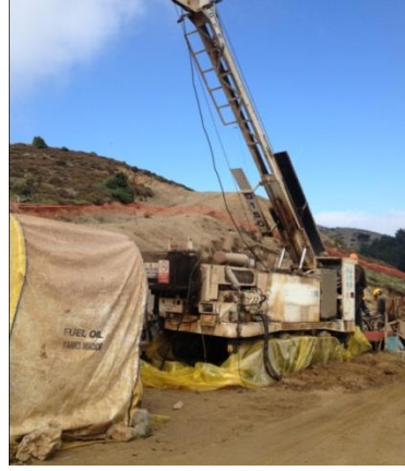
Resim 4.16. Gözlem yapılan sahalarda kullanılan koruyucu malzeme örnekleri
