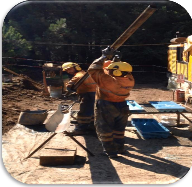
Resim 2.3. Karotun karotiyerden çıkartılması
