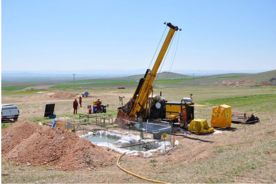
Resim 4.27. Gözlem yapılan sahalardan birinde yer alan sondaj sahası düzeni
