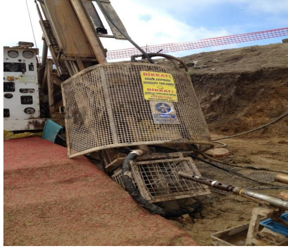
Resim 4.22. Gözlem yapılan sahalardan birinde yer alan izgaralarda kaymayı engelleyici malzeme
