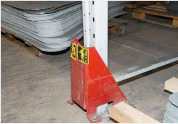
Şekil A.6.11: Kolon muhafazası örneği
