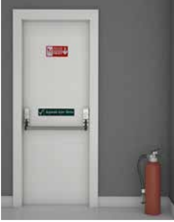
Şekil A.11.1: Acil çıkış kapılarının işaretlenmesi
