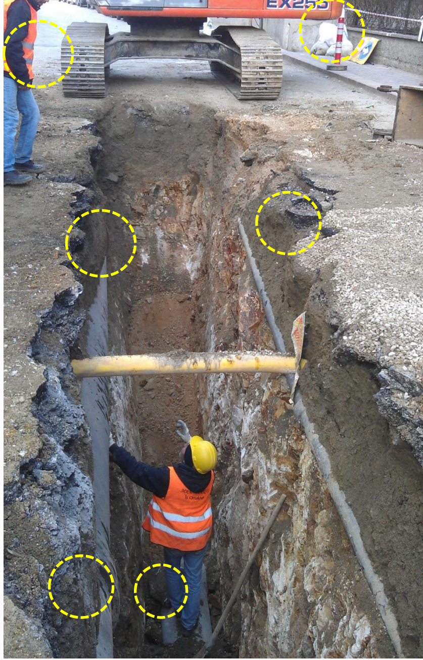
Şekil 4.6. Kayaç Zeminde Çalışma
