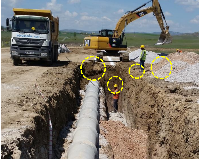
Şekil 4.9. Malzemelerin Yakına Yerleştirilmesi
