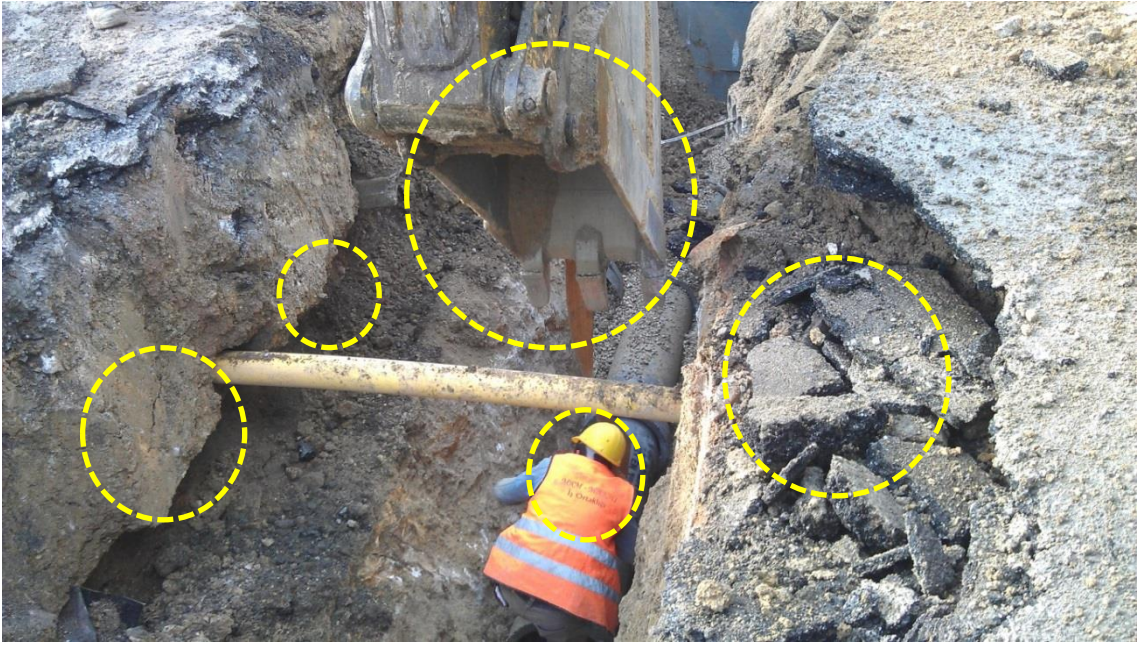
Şekil 4.2. Kova Altında Çalışma
