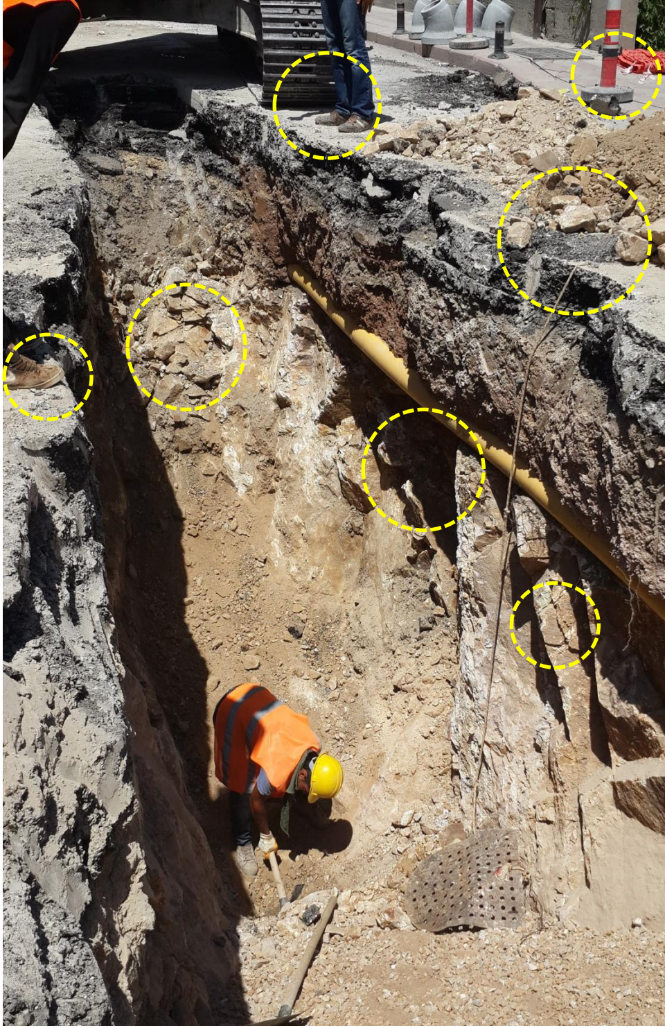
Şekil 4.8. Düşmeye Karşı Tedbir Almadan Çalışma
