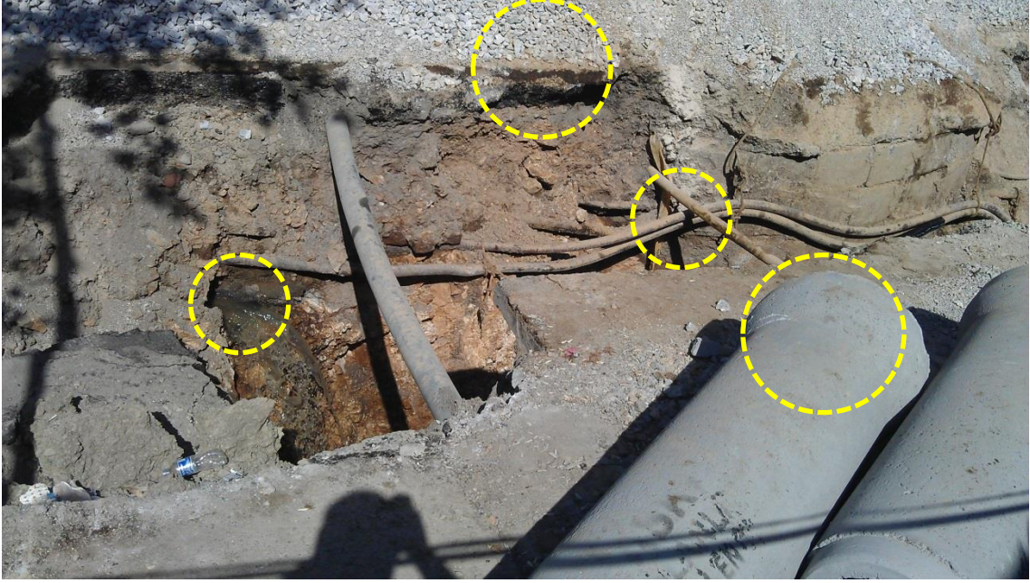
Şekil 4.11. Farklı Yer altı Hatları İçerisinde Çalışma
