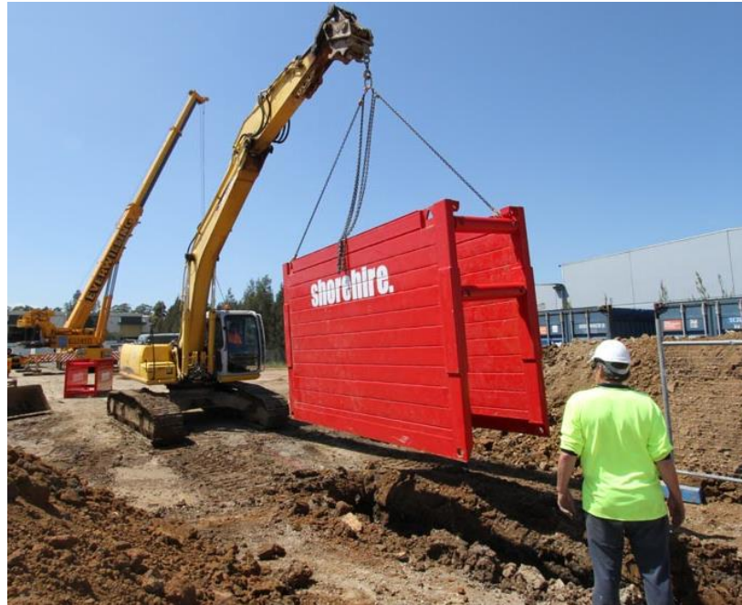
Şekil 4.23. Göçüğe Karşı Kalkanlı Sistem[43]
