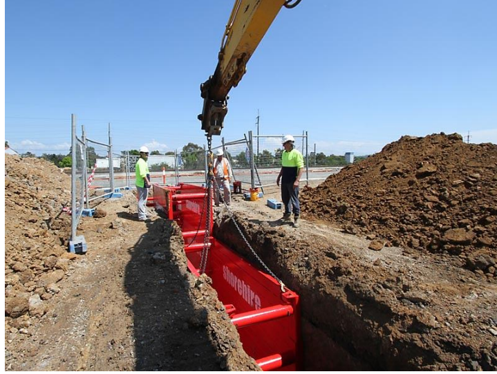
Şekil 4.36. Kazıda Standartlara Uygun Kalkan Kullanımı [48]
