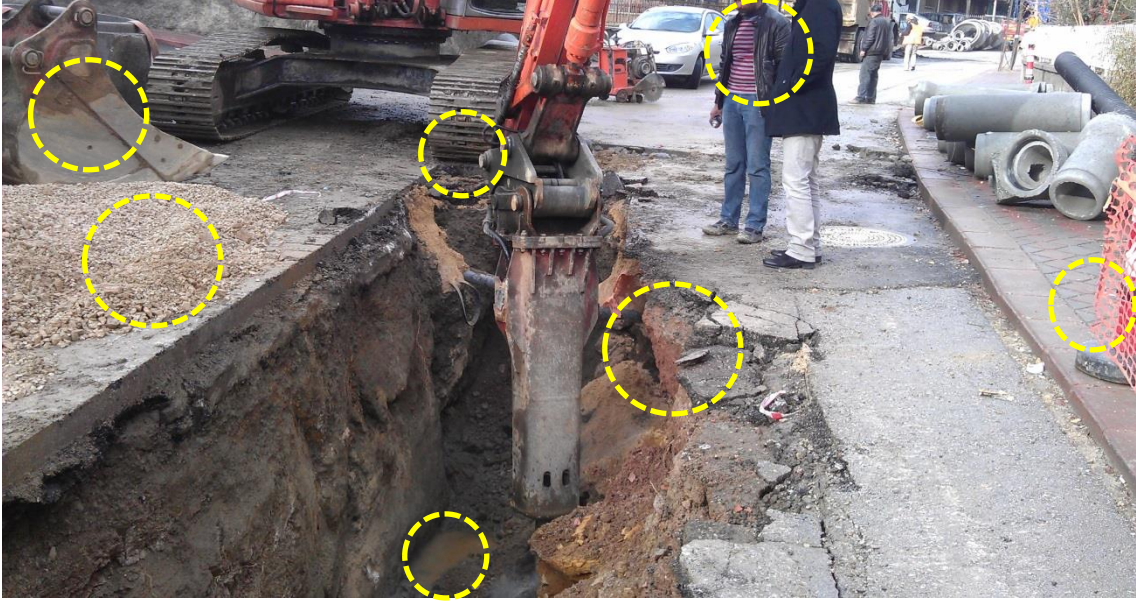
Şekil 4.5. Kazı Kenarına Malzeme Bırakılması
