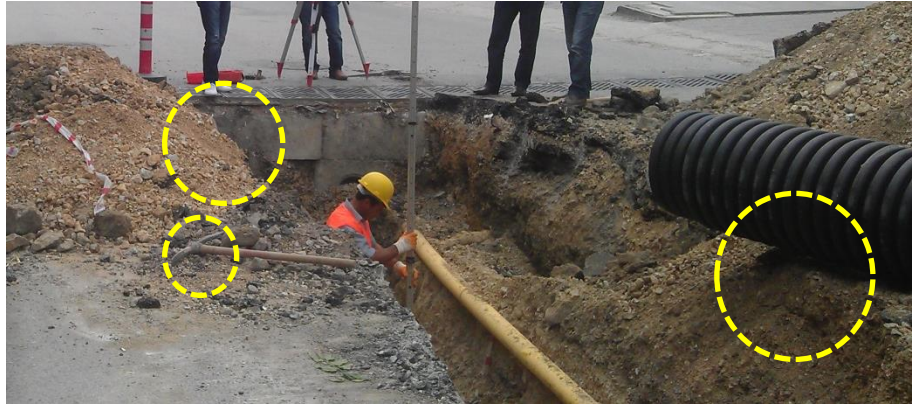
Şekil 4.12. Malzeme Kaymasına Tedbir Alınmaması
