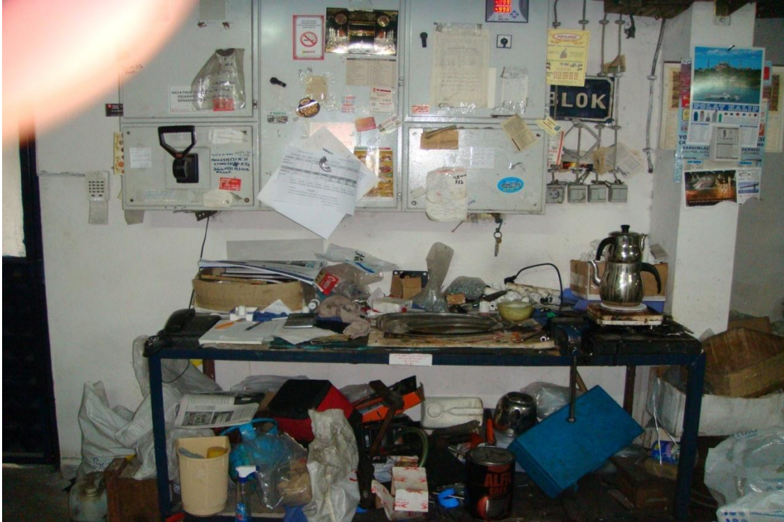
Resim 12. nceleme Yap,lan letmede Ana Elektrik alterinin Bulundu u Bölümdeki Düzensizlik
