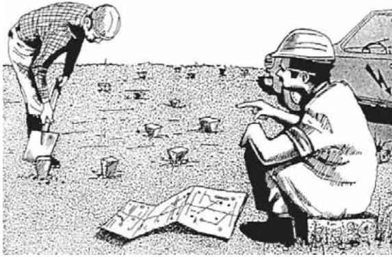
Şekil 34: Kazıdan önce yeraltı hizmetlerinin yerleri tespit edilmelidir 29 .
