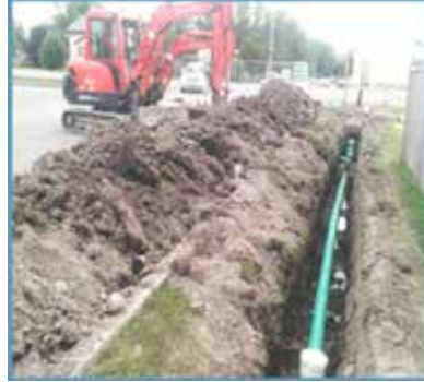
Şekil 11,12:Yığınlar kazıdan uzakta olmalıdır 16,17 .
