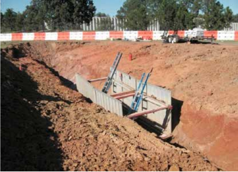
Şekil 25: Kalkalı dar kesitli kazı 26
