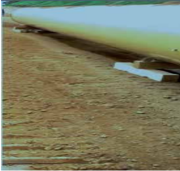
Şekil 11,12:Yığınlar kazıdan uzakta olmalıdır 16,17 .
