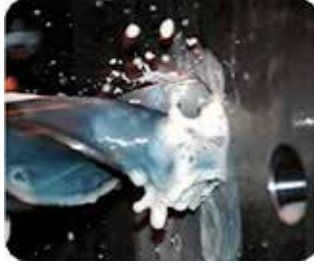
Resim 8. Aşırı köpük kullanımı (12)
