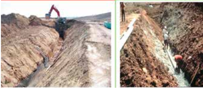
Şekil 20,21:Eğimli dar kesitli kazı 23,24
