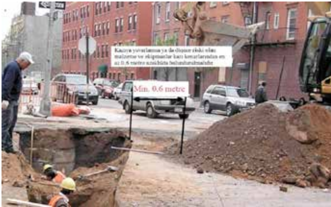
Şekil 32: Hafriyat yığını dar kesitli kazıdan yeterli uzaklıkta tutulmalıdır 28 .
