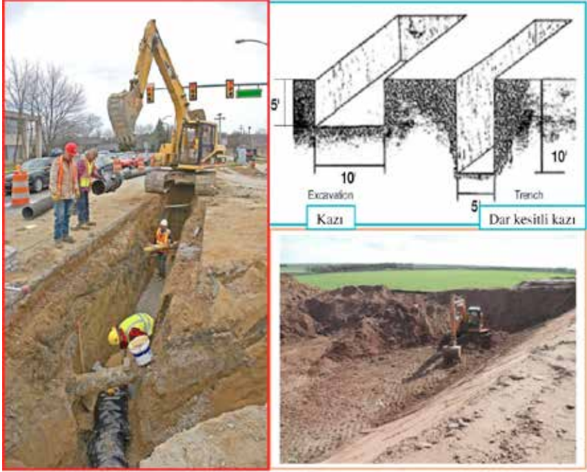
Şekil 1. Dar kesitli kazı ve kazı örnekleri 2,3,4
