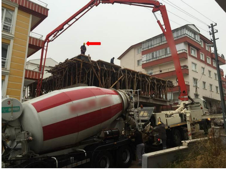
Resim 4.10. Döküm işlemi yapan pompa operatörü
