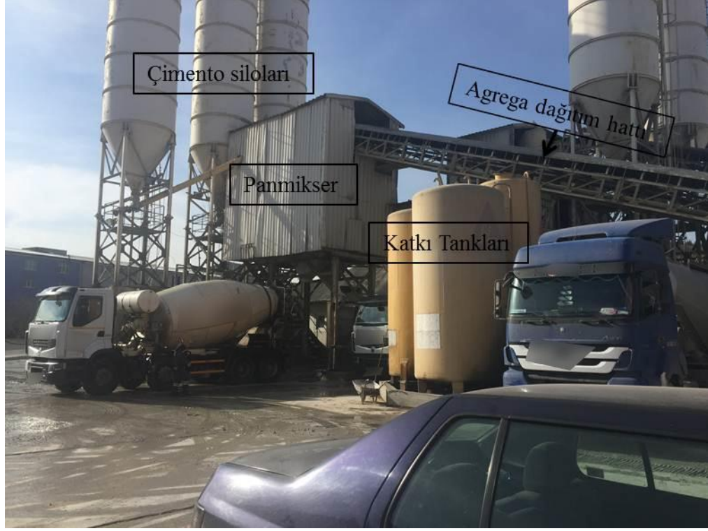
Resim 4.9. Beton santrali üretim kısmından bir görüntü
