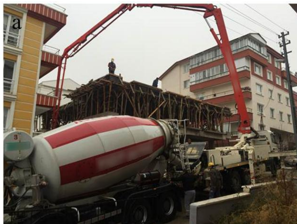
Resim 3.3. Kalıp dökümü
