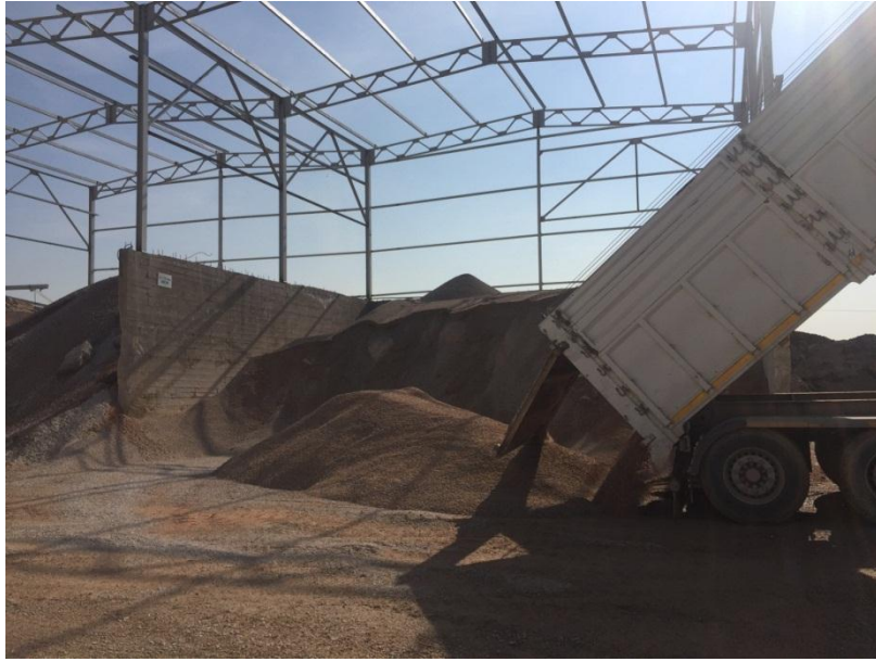
Resim 4.16. Agrega taşıyan kamyonun boşaltım işlemi
