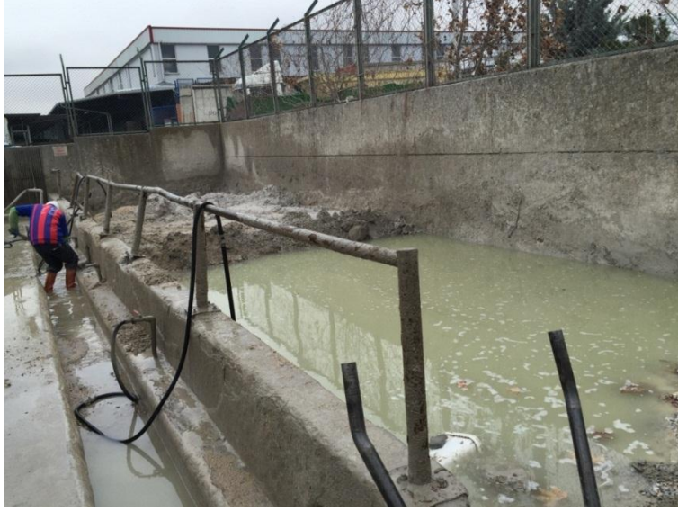
Resim 4.1. Atık su havuzunda bir çalışma
