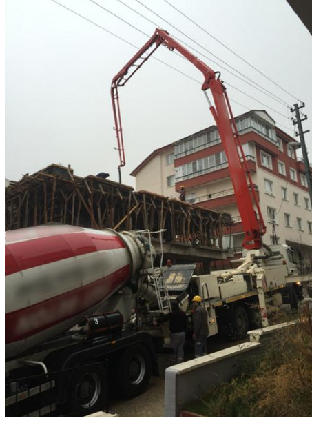
Resim 2.6. Pompayla döküm işlemi
