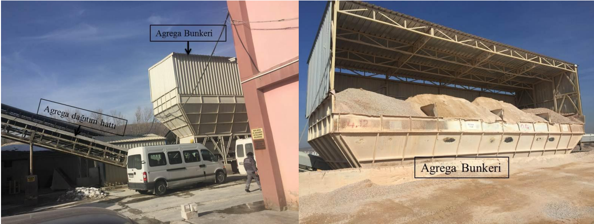
Resim 4.8. Agregaya bunleri ve agregaya dağıtım hattından görüntüler
