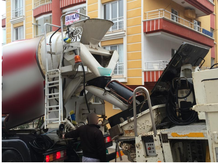
Resim 4.12. Transmikserden pompaya beton dökümü
