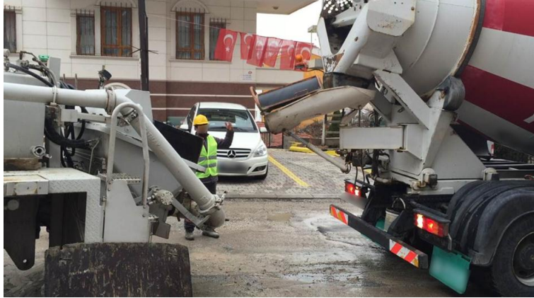
Resim 4.11. Pompaya döküm yapacak transmikserin yönlendirilmesi
