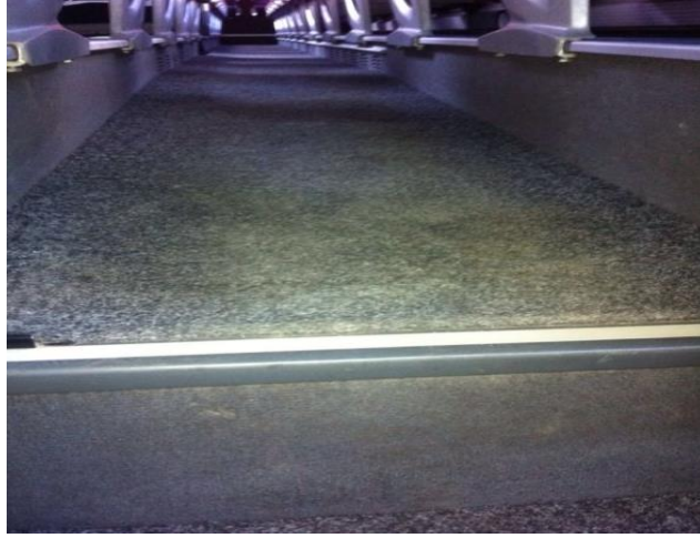
Şekil 12. Halıfleks ile Kaplanmış Koridor Zemini
