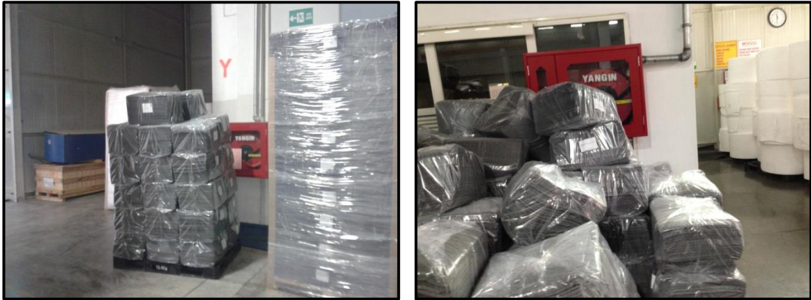
Resim 4.19. Yangın söndürme ekipmanlarının önlerine malzeme konulması
