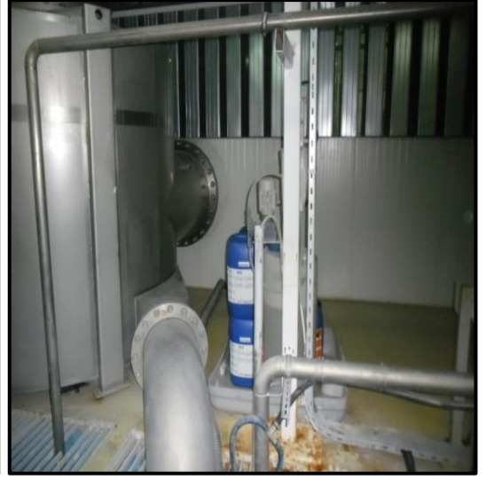
Resim 4.32. Kimyasalların diğer malzeme/ekipmanlarla birlikte depolanması, güvenlik bilgi formlarının bulunmaması ve kimyasalların depolanması için uygun alanlar oluşturulmaması
