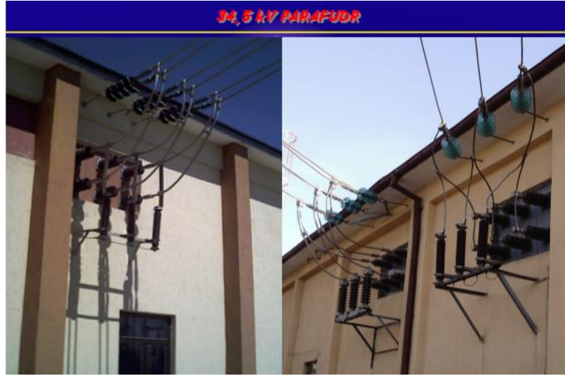
Şekil 20: 34,5 kV Parafudr Bağlantısına Örnek
