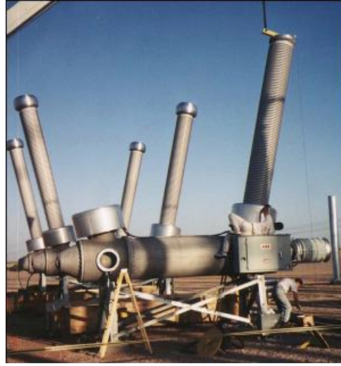
Şekil 13: Yüksek gerilim kesicisi
