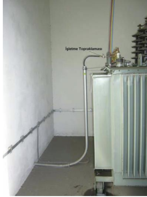
Şekil 11: İşletme Topraklaması Bağlantısı
