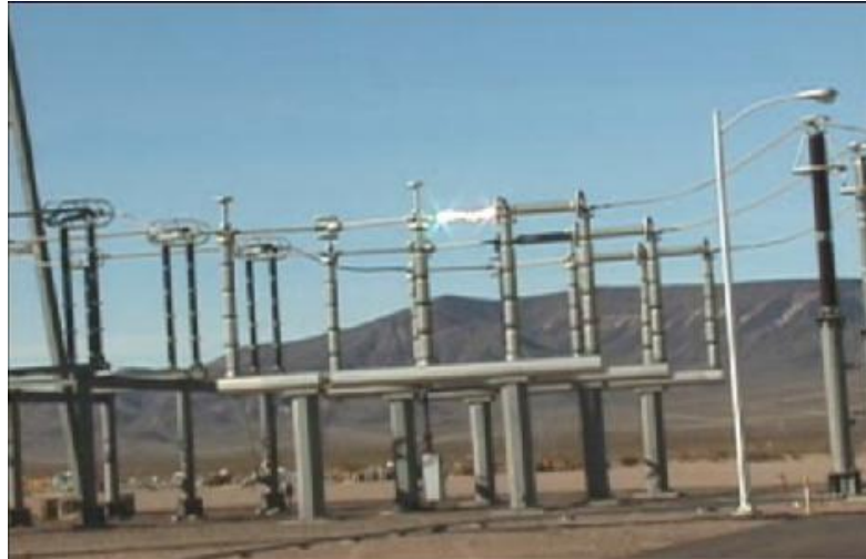
Şekil 14: Kesici açma işleri sırasında oluşan ark
