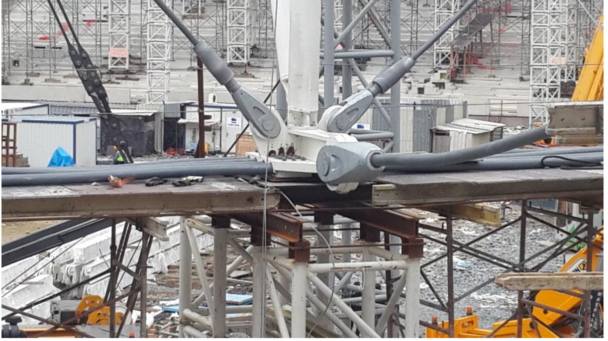
Resim 3.6. Çelik halatların çelik konstrüksiyon bağlantı bölümleri
