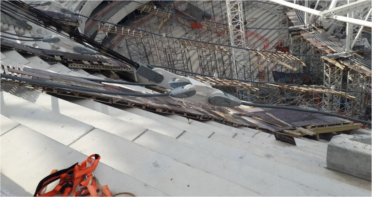
Resim 3.5. Çelik halatların hidrolik bağlantı bölümleri
