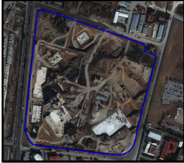
Şekil 3.3. İnşaat Sahası 1 Görünüşü
