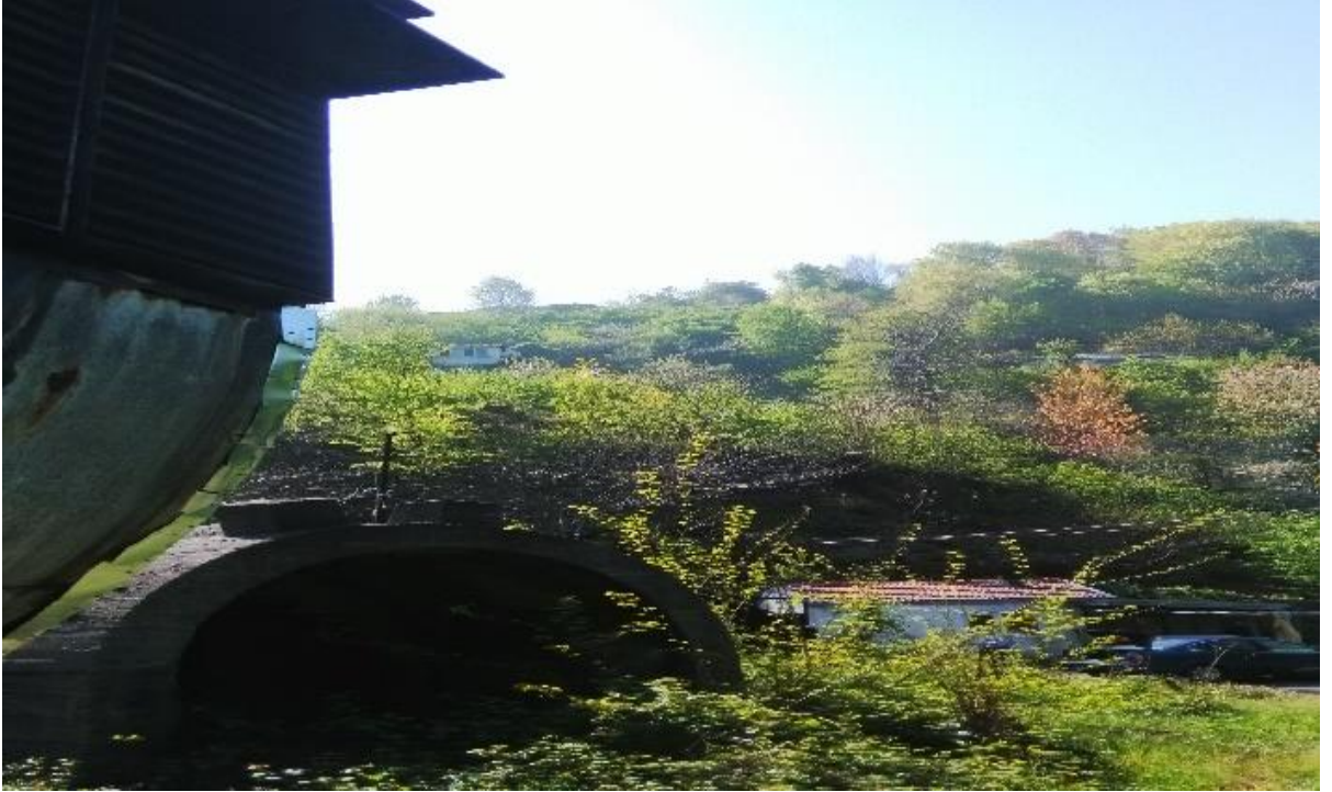
Resim A.3. Taş Kömürü Madeni I Nolu Kirlı Hava Tahliye
