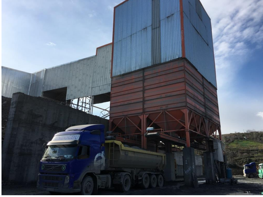
Resim 2.6. Ürün silolarından agrega yüklemesi
