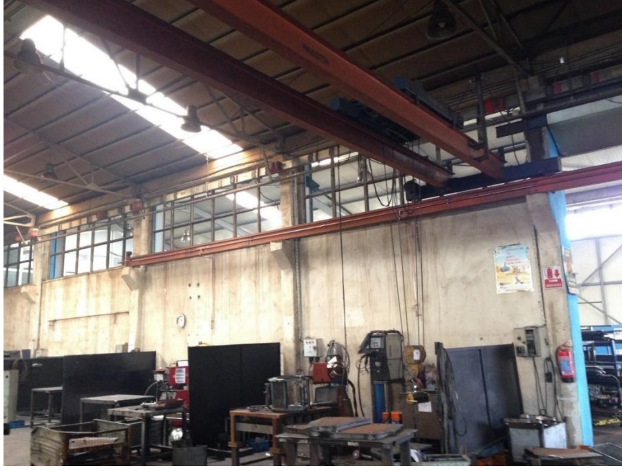
Resim 2.28. Gezer vinç ile malzemelerin taşınması
